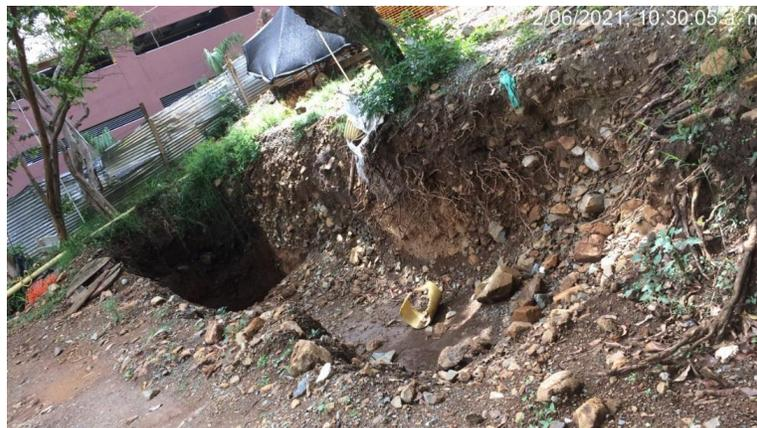
*Foto 6. Excavación que afectó el sistema radicular de los ejemplares arbóreos*
